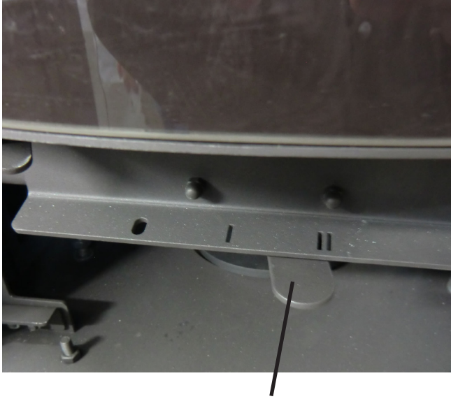
Palanca de uso para la entrada de aire de combustión
