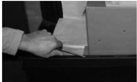
Abb. 2.7 Scheibenleiste herausheben.
