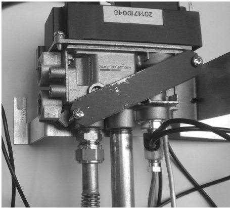
Abb. 2.27 Angeschlossener Gasregler (CARISMO 38, 63PS/ES, 85 und 2050)
