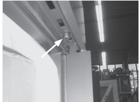
Abb. 2.58 Montage der senkrechten Blenden
