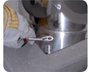
2. Grundplatte am bauseitig erstellten Fundament befestigen.
