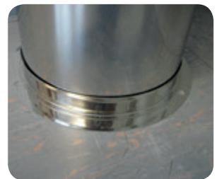
3. Fußteil am bauseitig erstellten Fundament befestigen.
