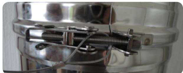
**3.** Sicherungsseil der Regenhaube am Verschluss des Klemmbandes befestigen.
