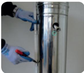
1. Fußteil auf die gewünschte Länge kürzen und wieder in die Auflageplatte einsetzen.
