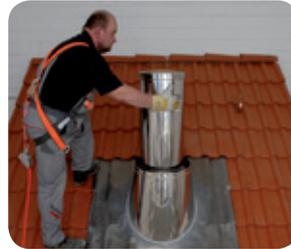
**3.** Rohrelement gemäß Standardmontagevorgang montieren. Die Dachdurchführung gleichmäßig und waagrecht zur Rohrsäule ausrichten.
