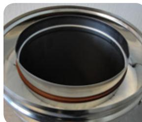
**2.** Bei Überdruckanlagen Dichtring über die Sicke des inneren Rohres spannen (auch bei jeder weiteren Verbindung).
