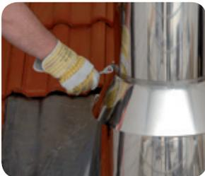
**5.** Regenkragen oberhalb der Dachdurchführung am Rohrelement versetzen und kraftschlüssig verschrauben. Weiter bis zum letzten Rohrelement.
