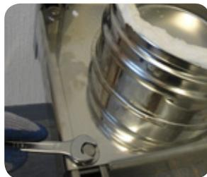
**6.** Grundplatte nun kraftschlüssig mit der Montageschiene verschrauben. Weiterer Montagevorgang siehe Putztüranschlüsse Seite 15.
