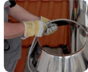
**4. Regenkragen-Montage:** Der Regenkragen ist oberhalb der Dachdurchführung am Rohrelement zu befestigen und abzudichten.
