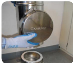
**1.** Putztüranschluss auf die Grundplatte bzw. das Fußteil montieren.
