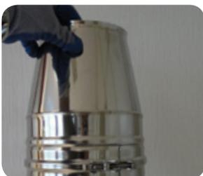
**1.** Mündungsabschluss montieren und mit Klemmband kraftschlüssig verschrauben.
