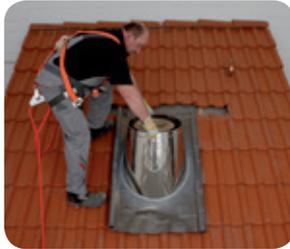
**2.** Dachdurchführung überstülpen und gemäß den jeweiligen Dachdeckerrichtlinien in die Dachkonstruktion einbinden (Spengler).
