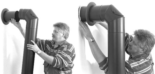
Abb. 13: Anschluss Rauchrohr am Schornstein
