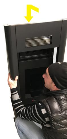
**Fig. 24 - Positionierung des Rahmens**
