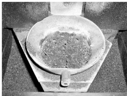
Abb. 33: Brennertopf verschmutzt
